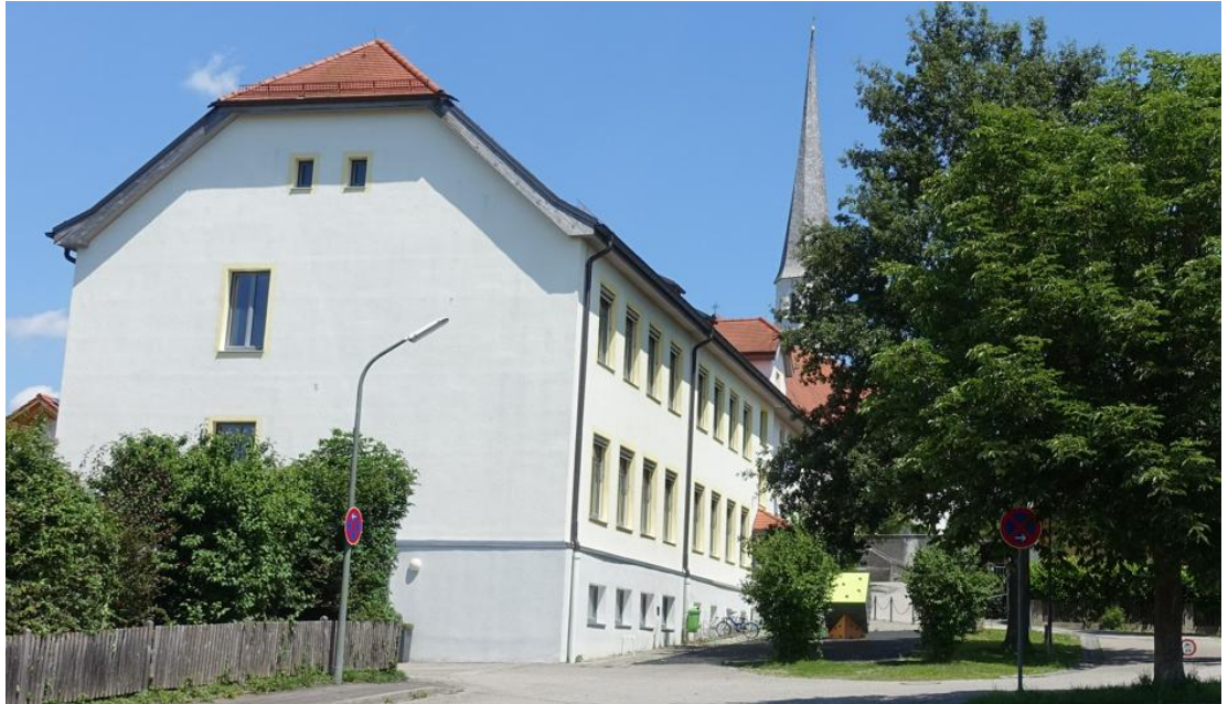
Abb. 22 altes Schulhaus; Wandhöhe Südwest ca. 10,20 – 10,30 m, Wandhöhen Nordost ca. 8,9 m; Foto PV, Stand 06/2020
