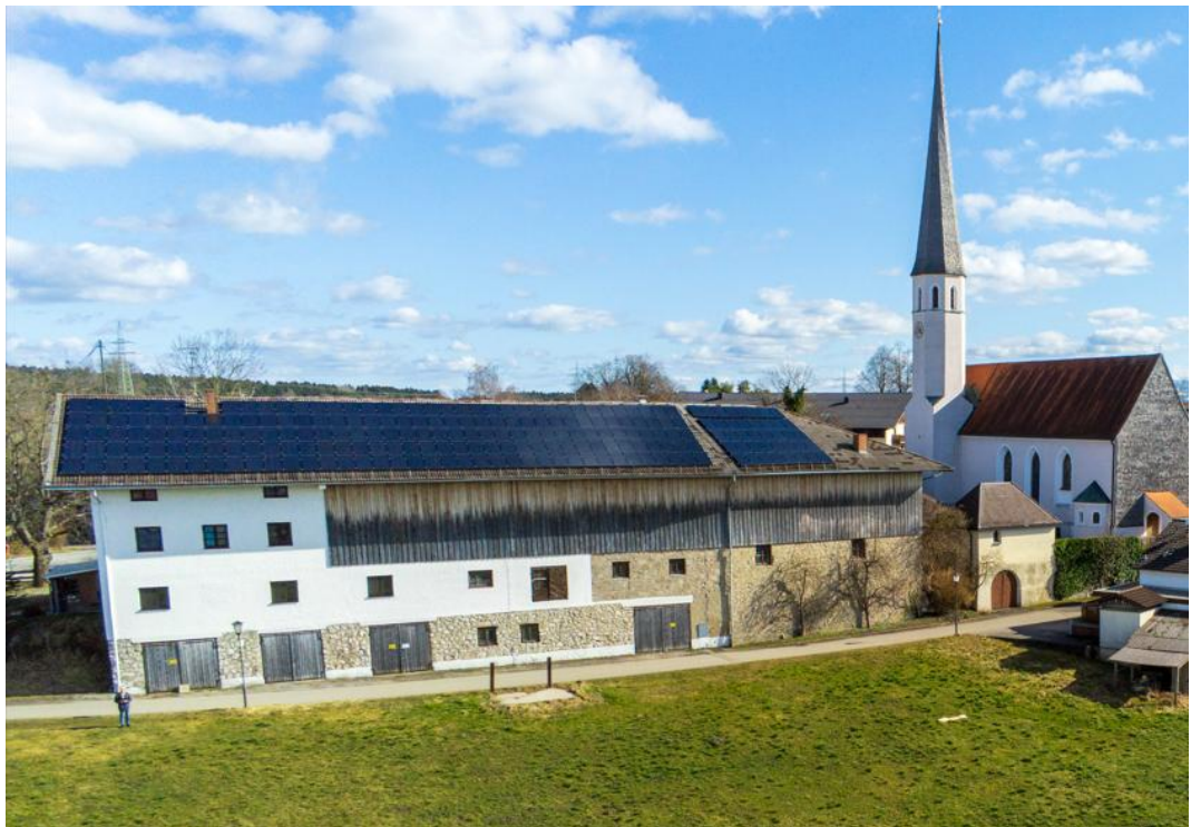
Abb. 21 Blick auf östlich und südöstlich gelegene Bestandsnachbargebäude; Wandhöhe Südwest: ca. 10,95 m bis ca. 11,20 m; Stand: 02/2022, Foto: Gemeinde
