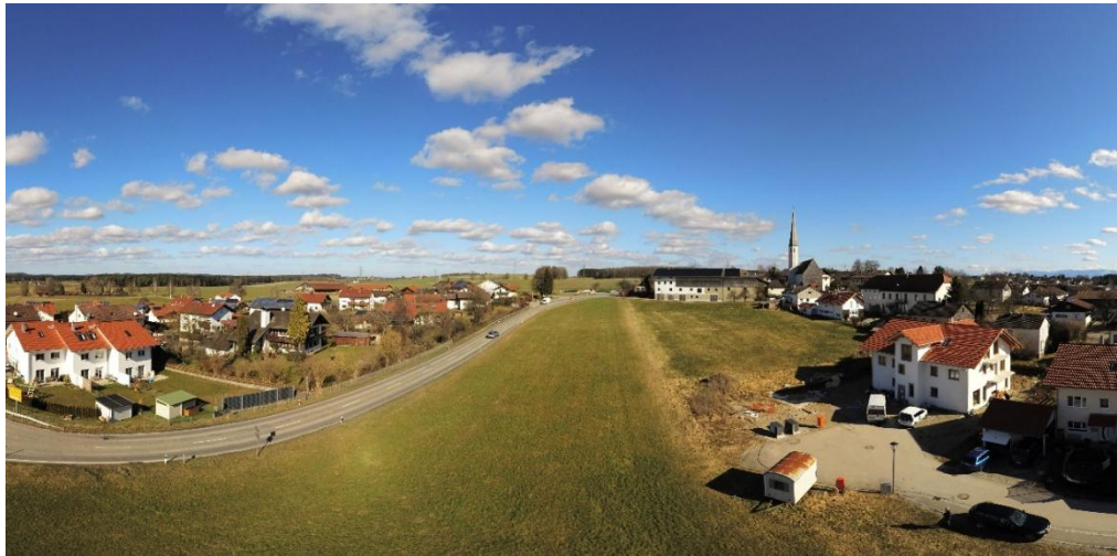
Abb. 1 Plangebiet, Blick Richtung Nordosten. Aufnahmedatum: 23.02.2022; Foto: Gemeinde
